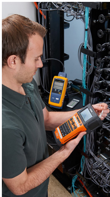
Figure 2. Les outils d'étiquetage peuvent accéder au Service Set Identifier dans la base de données SaaS pour enregistrer les nouvelles données saisies et éliminer les erreurs d'étiquetage.
